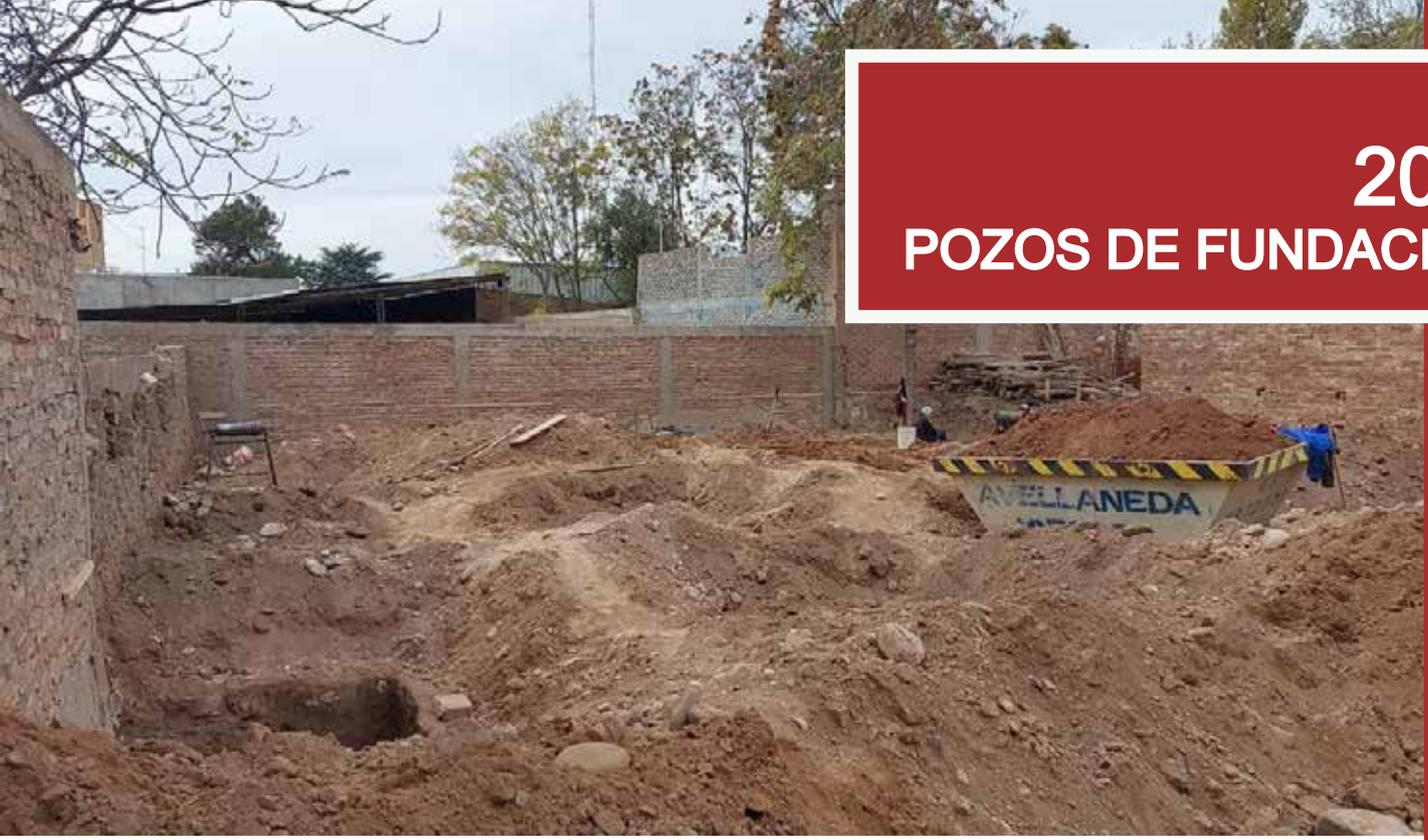
El avance del replanteo dio inicio a los trabajos en fundaciones, comenzando la excavación de los pilares de fundación y el armado de sus canastos internos.
