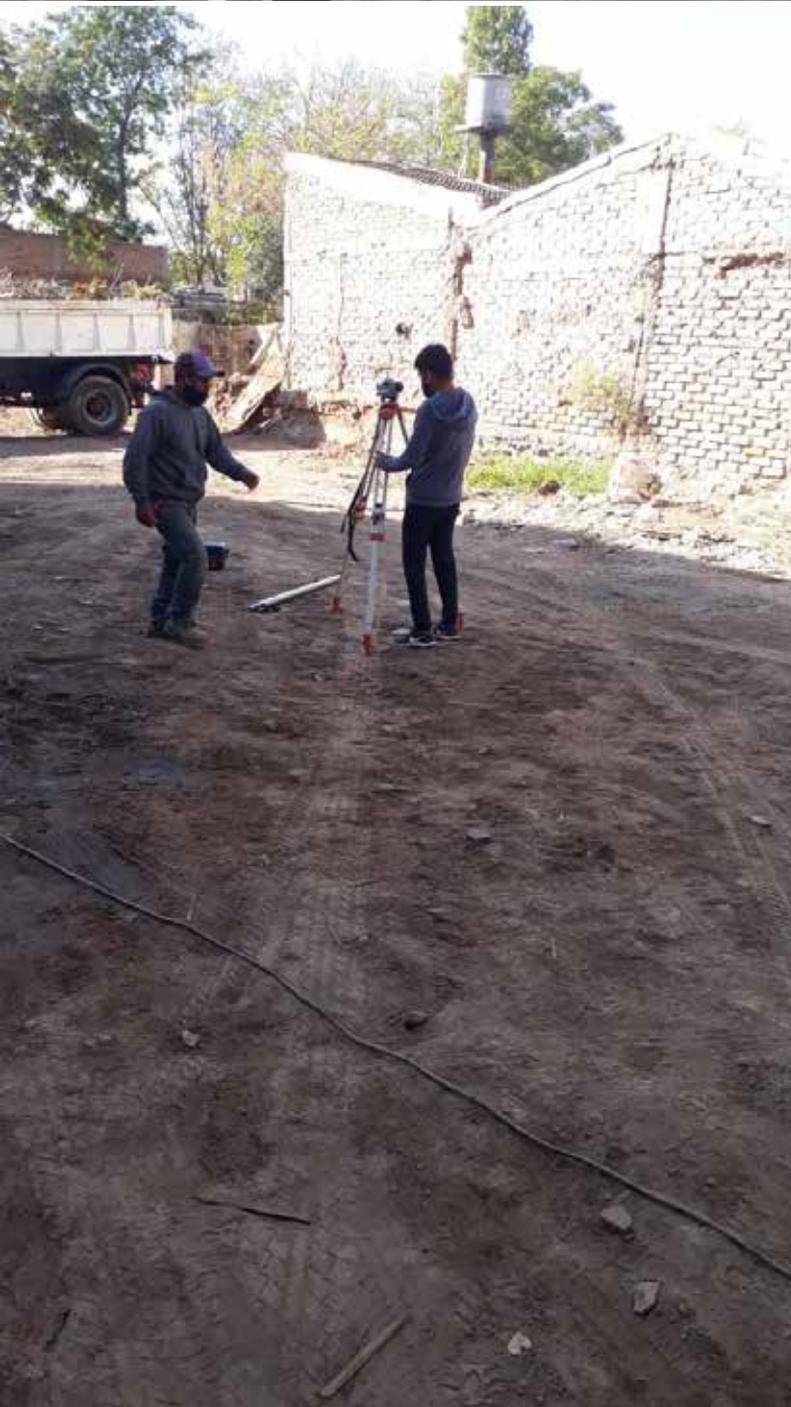
Por otra parte, una vez que el terreno quedó limpio y nivelado, se procedió a realizar el replanteo del edificio, lo cual consta en precisar en el terreno la ubicación de las fundaciones y de los principales elementos estructurales a partir de lo cual se empieza a levantar la construcción.
