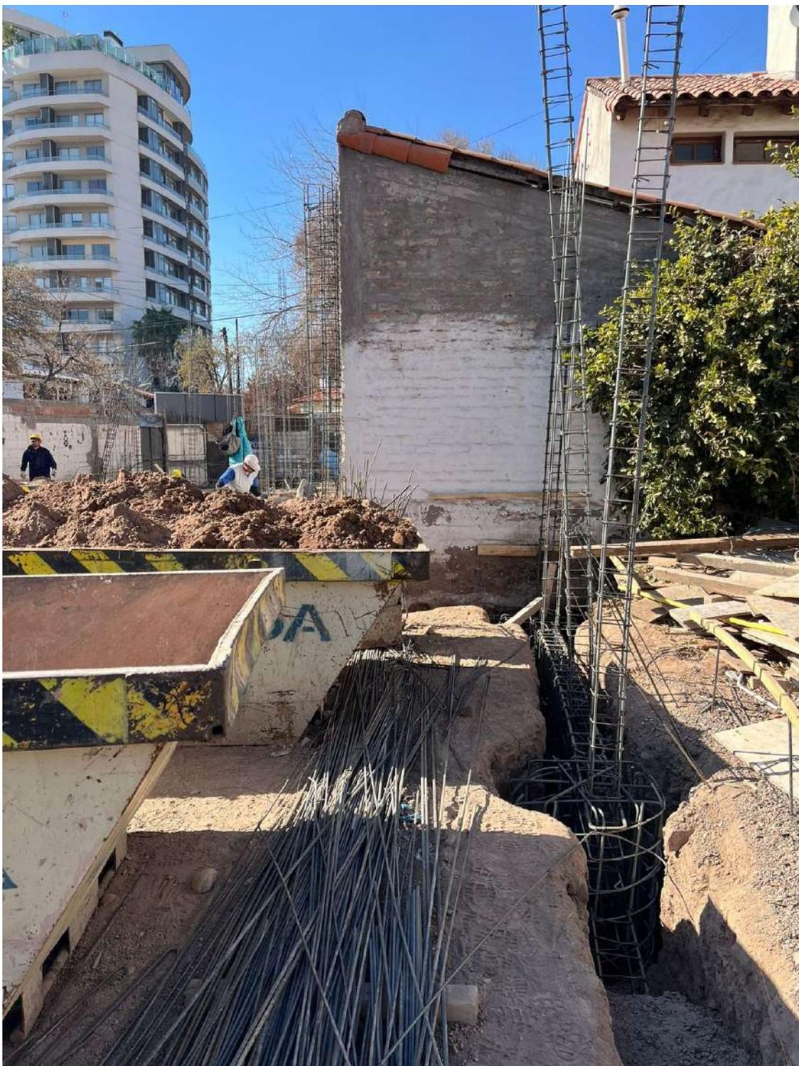
Mientras avanzamos con columnas y tabiques vamos armando los hierros internos de las vigas de fundación del edificio.
