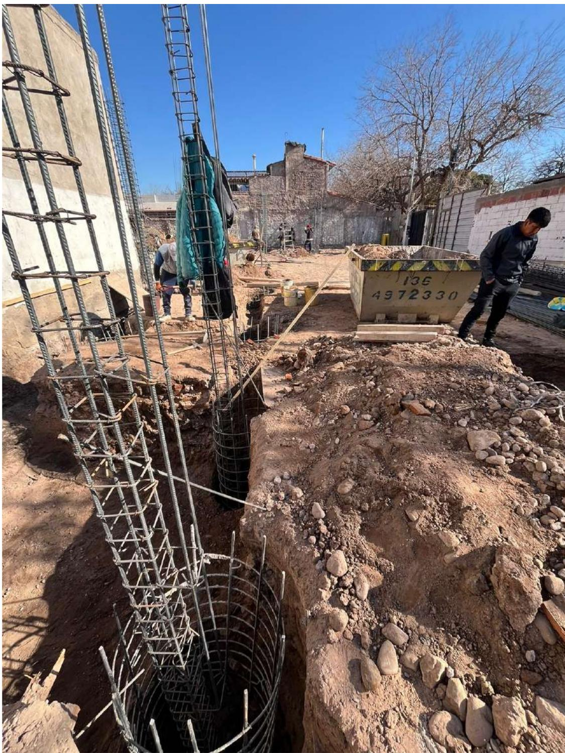
En el mes de Junio, mientras avanzamos con el armado de canastos de pozos de fundación y con el llenado de los mismos, empezamos a levantar las primeras columnas de Planta Baja. En simultáneo también se fueron armando algunos tabiques.
