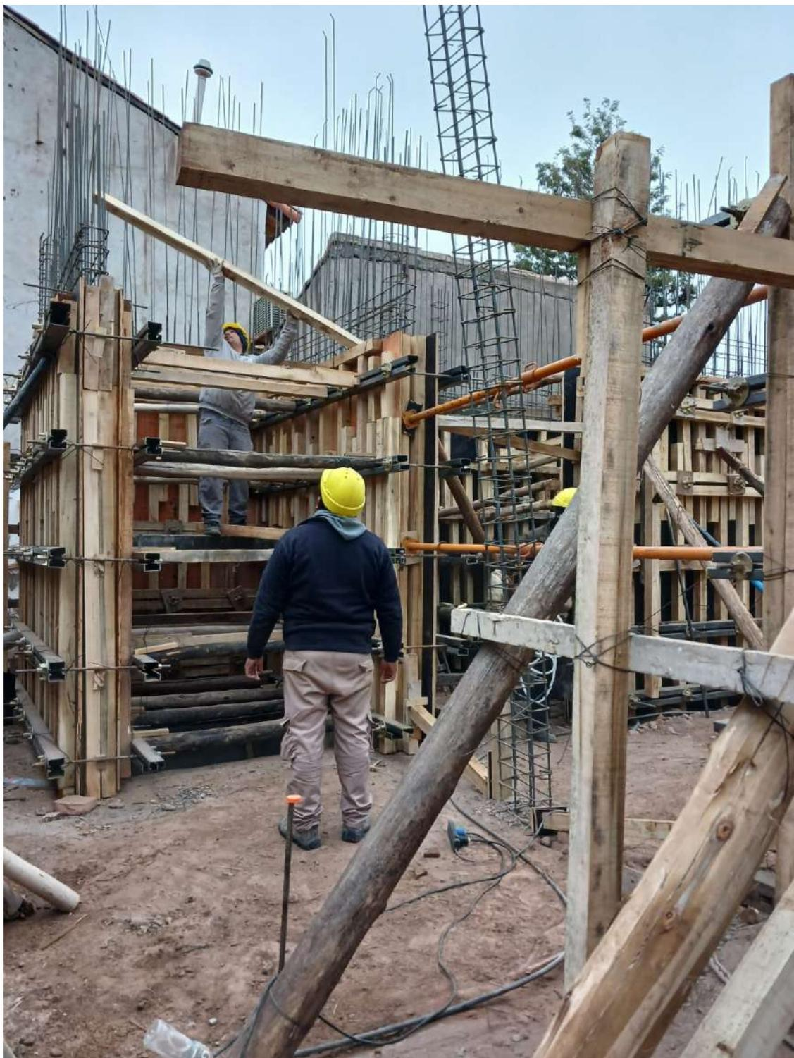
Antes de verter hormigón en tabiques y columnas, realizamos la ardua tarea de armado de hierros, encofrados y apuntalamiento.
