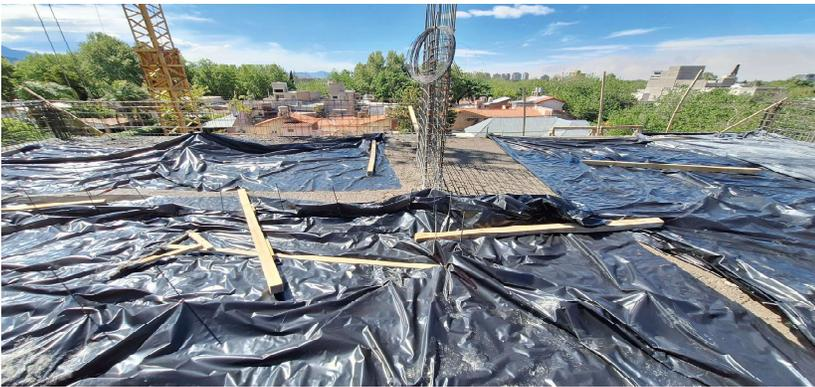
La losa ha sido cubierta con nylon para asegurar una adecuada humedad durante su proceso de fraguado, garantizando así una correcta consolidación del hormigón.
