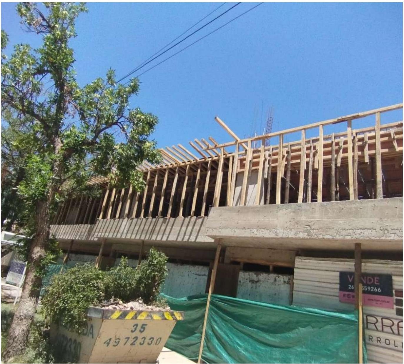
El hormigonado de losas es un hito en los trabajos de obra. Para ese día, no solamente tenemos que tener listos encofrados y puntales, sino también cañerías eléctricas y pases para instalaciones, trabajos en los que estamos avanzando arduamente!
