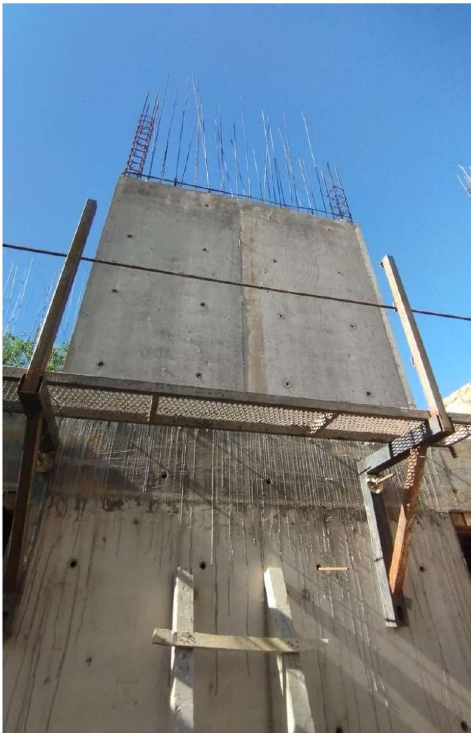
Al día de la fecha ya contamos con todos los tabiques de Primer Piso desencofrados y todos los muros de ladrillo levantados. Esto permite que, luego de hormigonar las losas sobre este nivel, podamos empezar a colocar cerramientos livianos en cada departamento.
