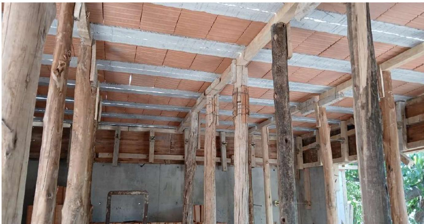
Junto al hormigonado de losas, llenaremos vigas. Por esto, hoy en día ya tenemos estos elementos estructurales listos, encofrados y apuntalados. También, se llenará el segundo tramo de escaleras.
