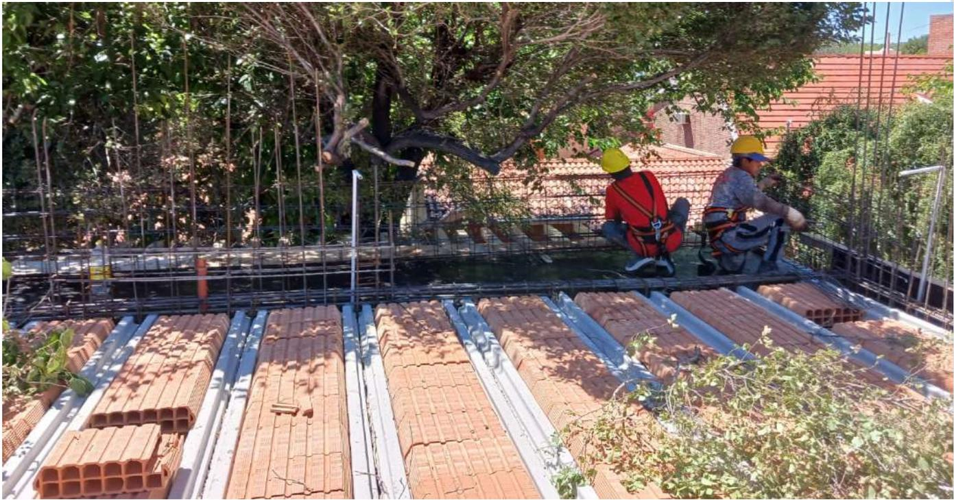
El próximo desafío que tenemos en obra es hormigonar las losas sobre Primer Piso. Este trabajo se realizará en los próximos días por lo que, ya izamos viguetas, colocamos losetas y apuntalamos. Ahora empezaremos a colocar mallas, mientras terminamos de armar las armaduras de las losas macizas de este nivel.
