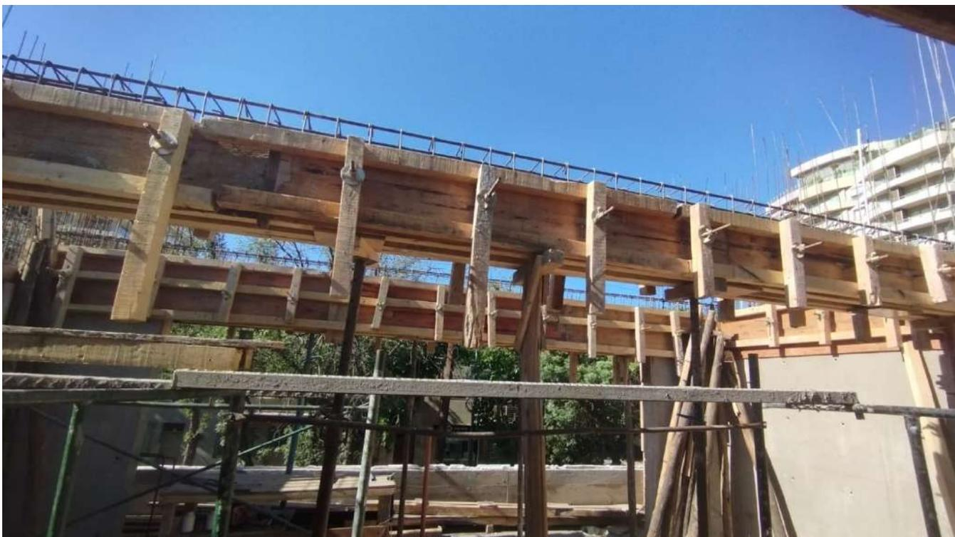
En el mes de Octubre iniciamos el parado de mampostería del primer nivel del edificio. Previo a esto, armamos hierros de columnas y tabiques y, luego de terminar de colocar ladrillos, enconframos y procedimos al hormigonado de estos elementos estructurales.
