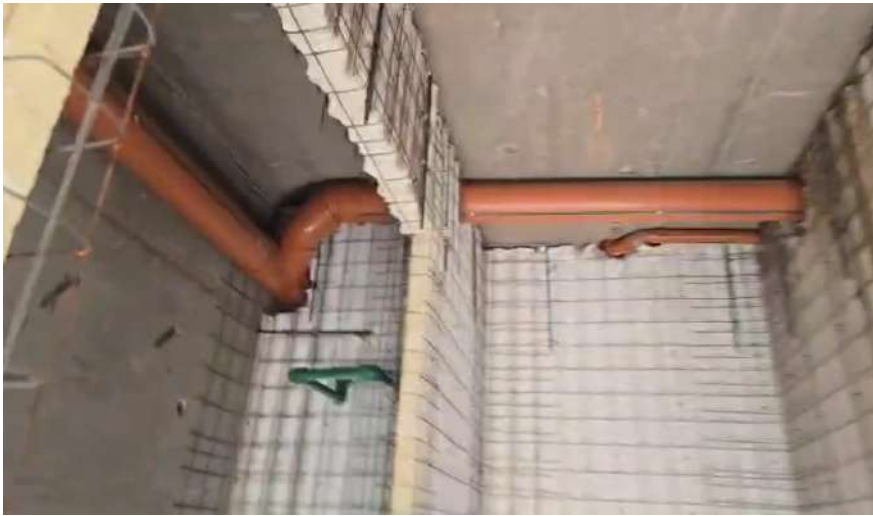
INSTALACION DE CAÑERIA DE CLOACA
