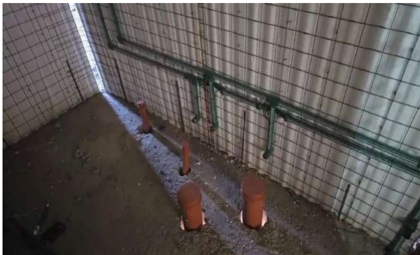
INSTALACION DE CAÑERIA DE AGUA FRIA Y CALIENTE
