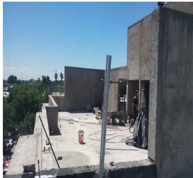
En cuanto a los revoques exteriores, se alcanzó aproximadamente un 90 % de avance, quedando los mismos prácticamente listos para la ejecución de la terminación con revestimiento, faltando detalles. Asimismo, se completaron los recuadros y revoques de las barandas en las fachadas este, norte y sur, dejándolas en condiciones para iniciar la etapa de texturado.
