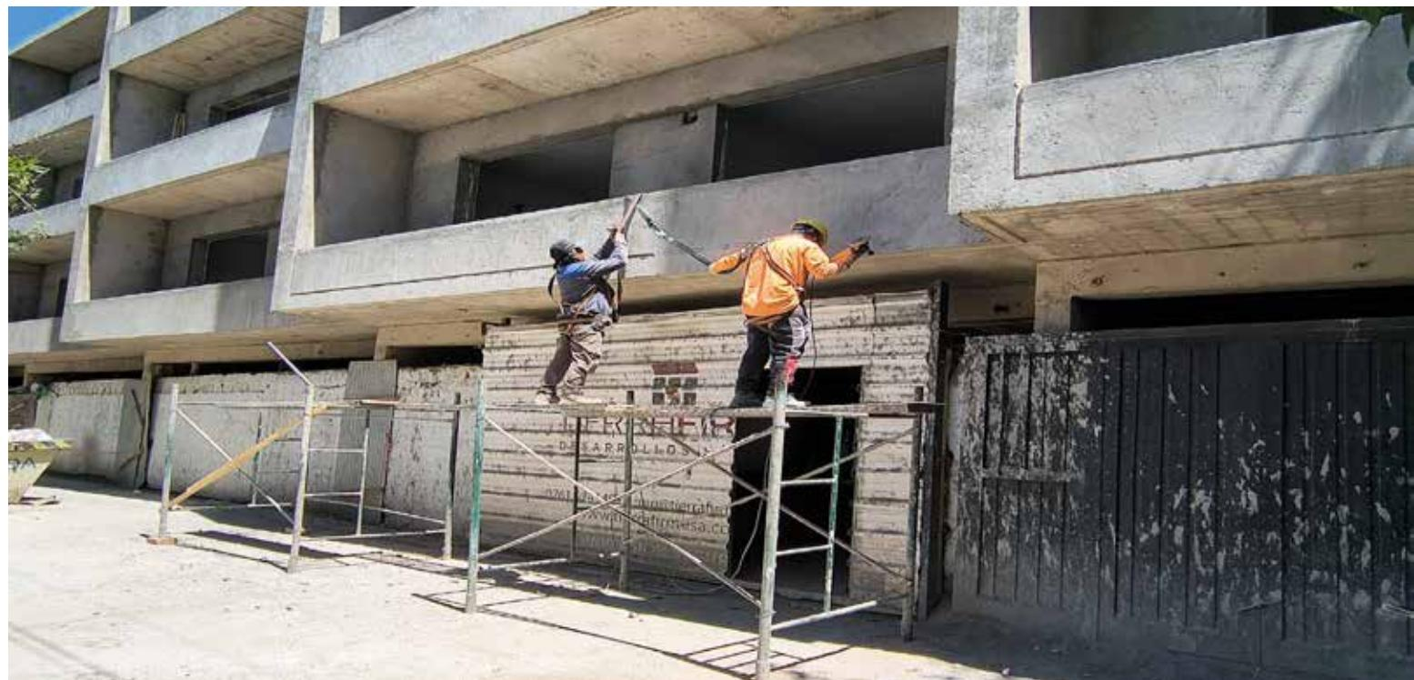
Se iniciaron los trabajos de preparación de la caja de escalera, dejando las superficies en condiciones para el ingreso del yesero y la aplicación del revestimiento de yeso. En fachadas, se avanzó con la colocación de perfiles para definir cortes de pintura y detalles, preparando las superficies para el revestimiento plástico, dando continuidad al cronograma de obra.
