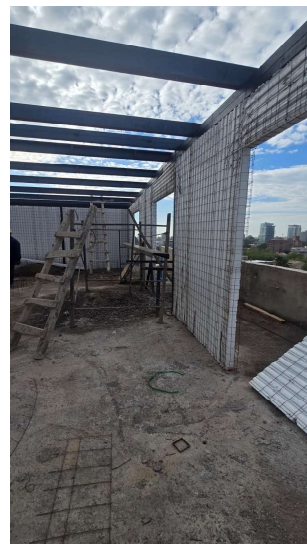
8° Piso estructura metálicas
