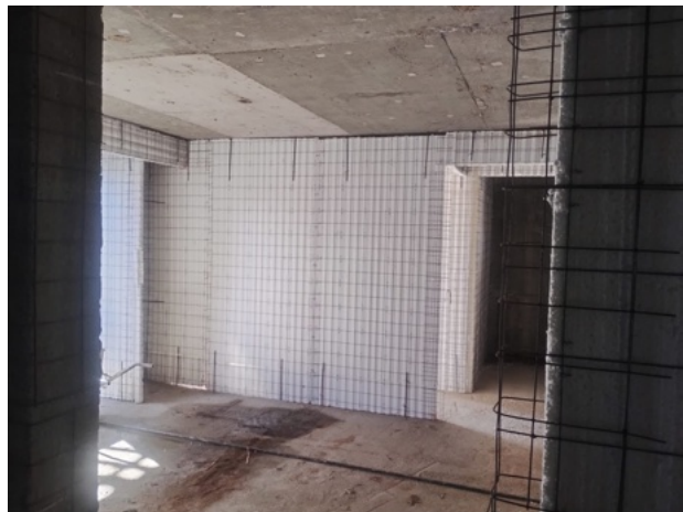
Paneles EPS EN 2° PISO
