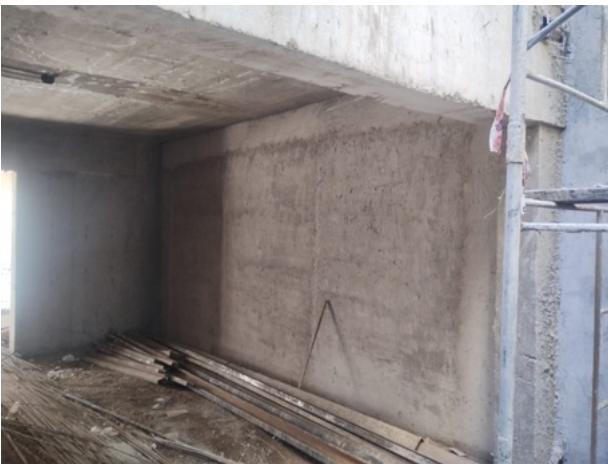
Revoque en planta baja
