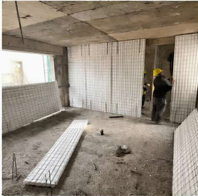
Colocación de paneles en el 4º piso Instalación sanitaria
