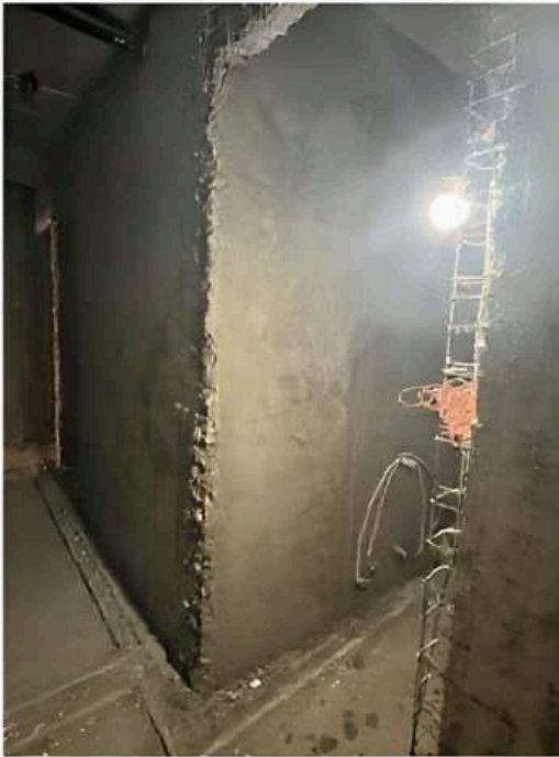
Revoque muros internos Instalación sanitaria
