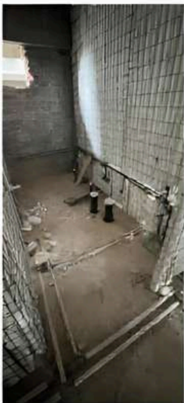
Revoque muros internos Instalación sanitaria
