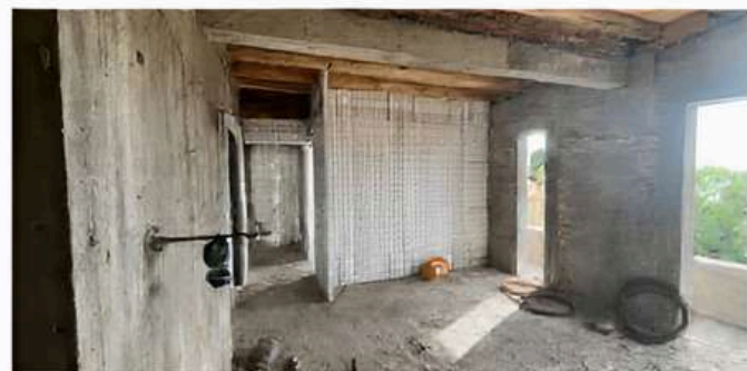
Colocación 4º piso
